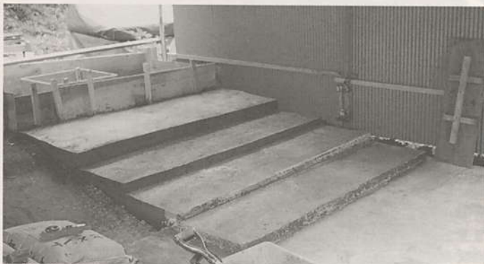
基礎の上にセメントで傾斜角度を考えながら窯の底を作る
