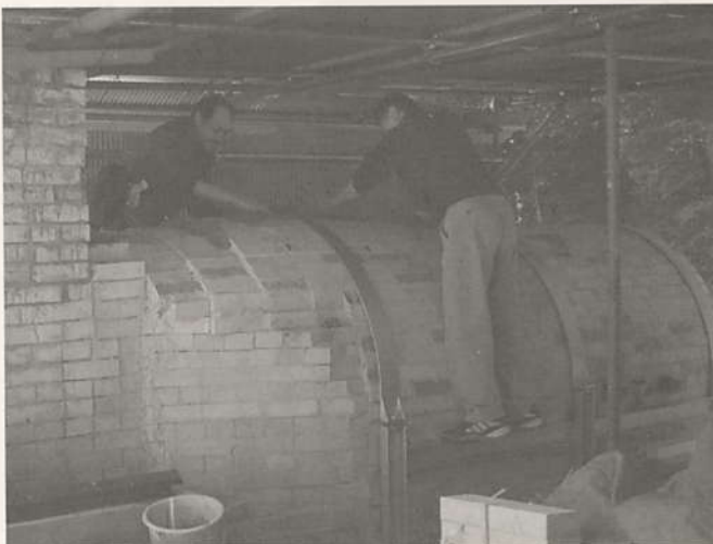
窯外側の耐火煉瓦の隙間を砂を混ぜた粘土で補修する参加者
