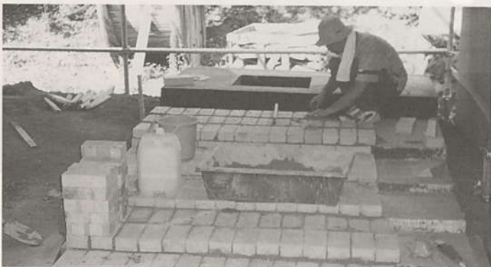
耐火煉瓦を敷き詰めていく
